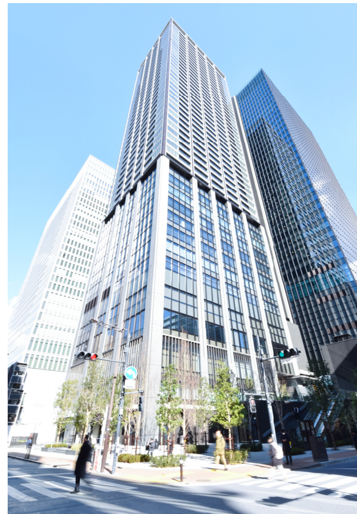
WTC annex 外観
